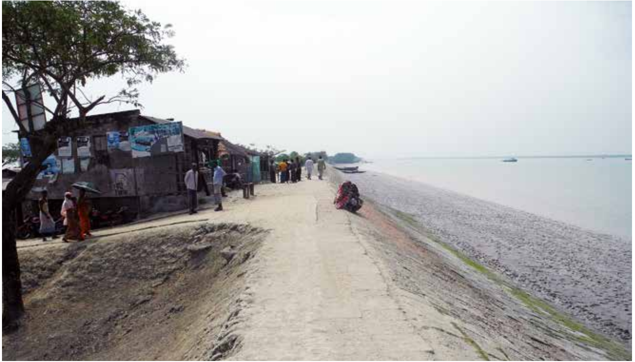
Deiche sollen in den Sundarbarns Schutz vor Überschwemmungen bieten.
